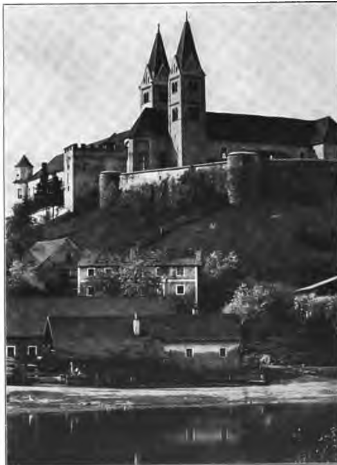
Fig. 87. Reichenbach. Nordostansicht des Klosters.
